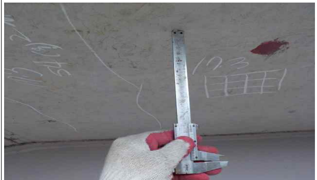
탄산화 시험(버니어캘리퍼스 측정)
