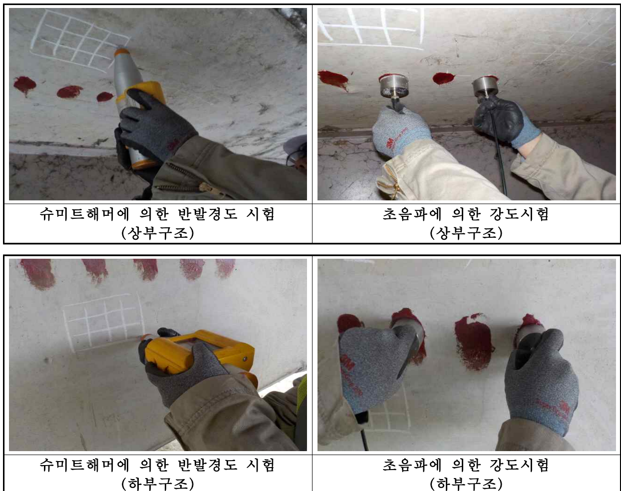
<그림 3.2.1> 콘크리트 비파괴강도시험현황
